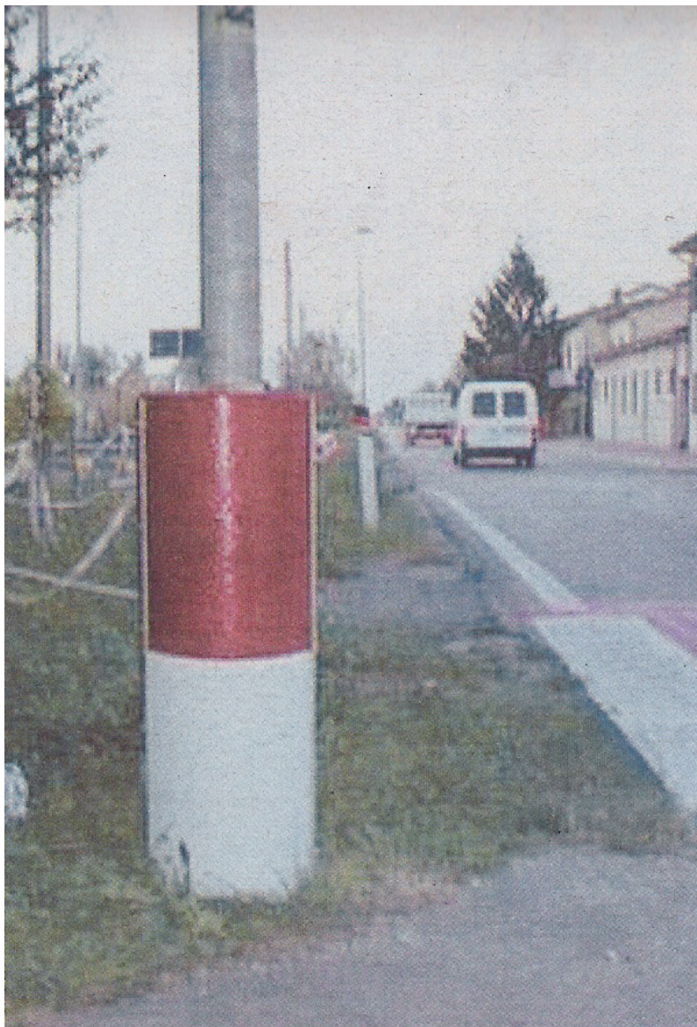
Il cordolo soffice che evita danni ai motociclisti in caso di urto
